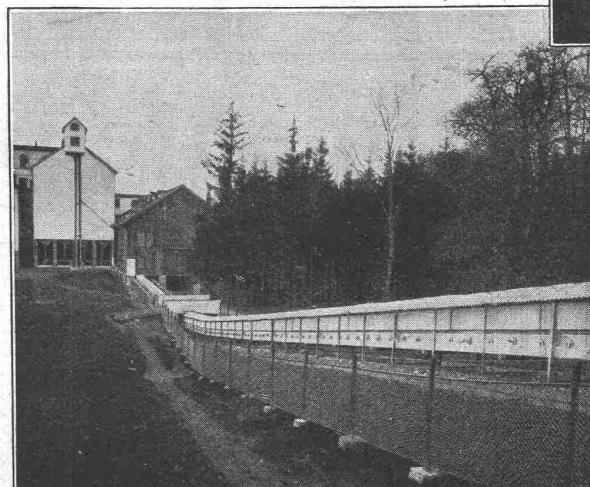
den Bilder zeigen eine den Vereinigten Mühlen A.-G. Goldach gelieferte Bühler-Transportanlage, welche eine Transportband-Länge von 220 m aufweist. Die Anlage besorgt in der einen Richtung die Zubringung des losen Weizens vom Bahnwagen zur Mühle und in der andern Richtung die Förderung des Weizenmehls in Säcken von der Mühle zum Bahnwagen. Das Transportband hat dabei an- und absteigendes Gelände zu überwinden. Das uns von der Besitzerin zugestellte Zeugnis erscheint in nächster Nummer.
