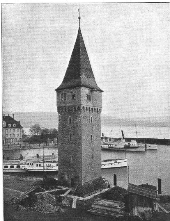
Wiederherstellung und Sicherung des alten Leuchtturmes in Lindau i. B. durch Zementeinpressung. Ausgeführt im Auftrage des Kgl. Bayerischen Landbauamts in Kempten.
