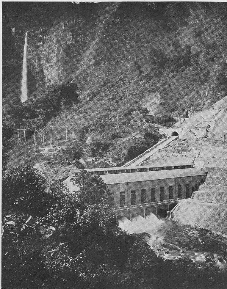
Abb. 5. Kraftwerk «Salto Grande» am Necaxafluss.
