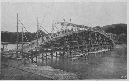
Abb. 3. Lehrgerüst der Aarebrücke vom linken Ufer aus.
