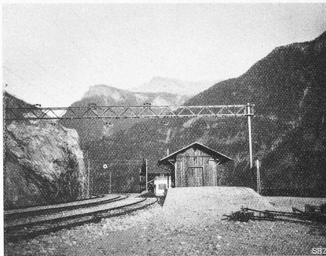
Abb. 34. Normale Zwischenstation (Lalden auf der Südrampe).
