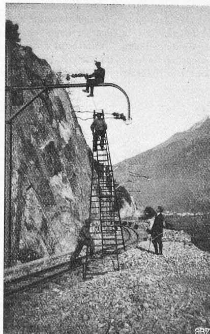
Abb. 38. Drahtmontage oberhalb Brig.
