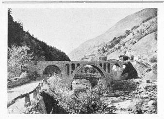
Abb. 7. Nussbaum-Viadukt bei Mörel, Hauptöffnung 25 m.
