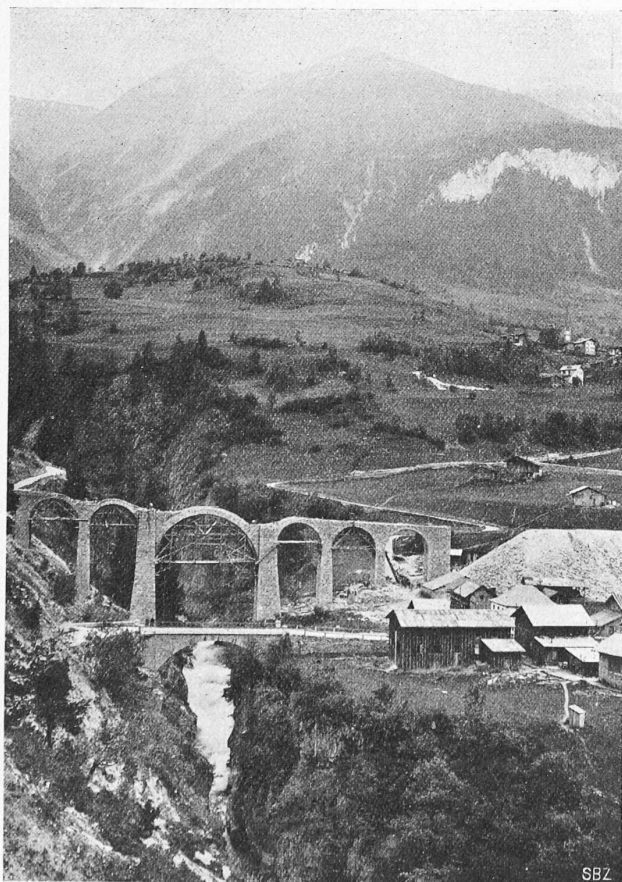
Abb. 11. Gengiols-Viadukt im Bau, Hauptöffnung 22 m.
