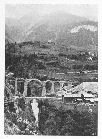
Abb. 11. Grengiols-Viadukt im Bau, Hauptöffnung 22 m.
