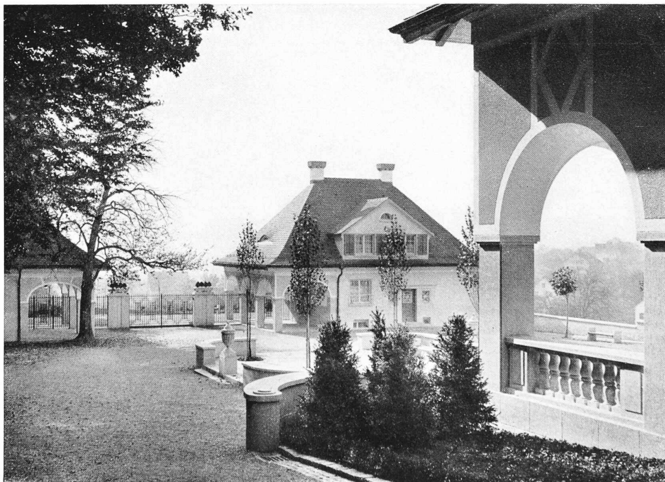
ARCHITEKTEN RITTMAYER & FURRER, WINTERTHUR
