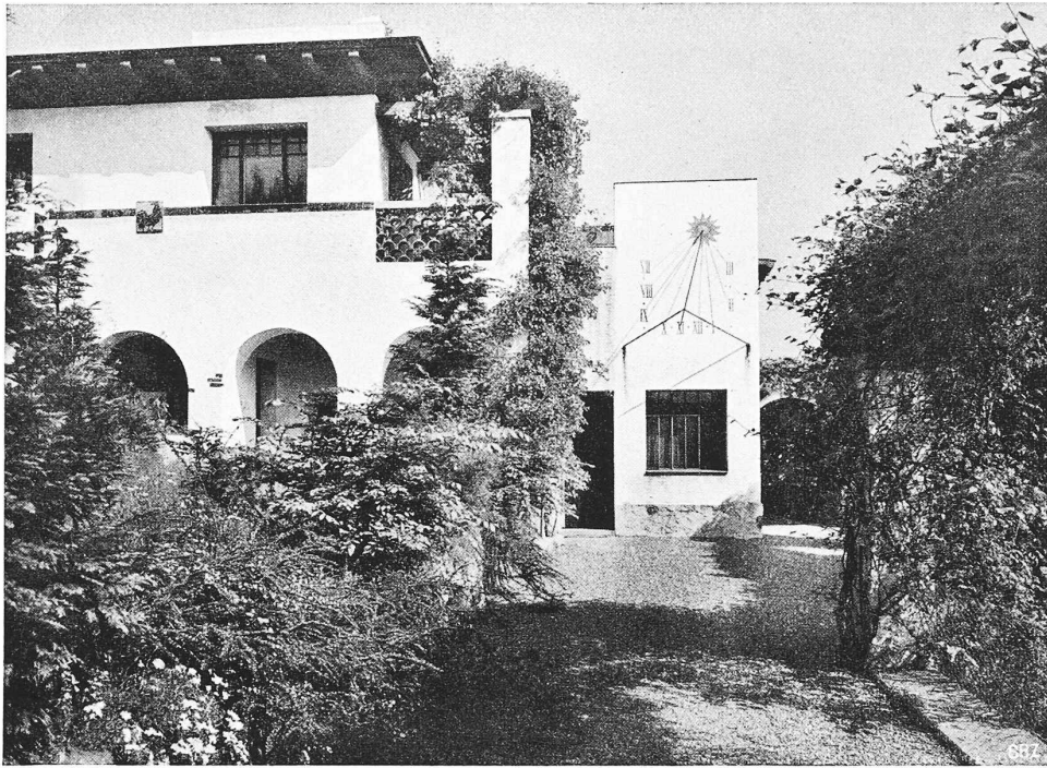
BLICK VOM SÜDLICHEN SITZPLATZ GEGEN DAS HAUS
