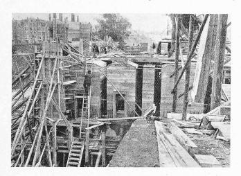
Abb. 22. Schalung für den Eisenbeton-Aufbau (Spandrillmauerwerk) über Flusspfeiler (24. VI. 13).
