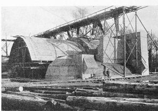
Abb. 21. Wie Abb. 20, jedoch Lehrgerüst in die nördliche Gewölbehälfte verschoben (1. XI. 12).
