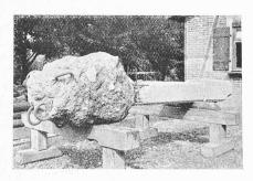
Abb. 26 und 27. Zerstörte und wieder versinterte Eisenbetonpfähle der Proberammung.
