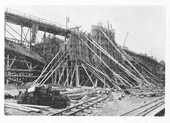
Abb. 23. Wie Abb. 22, aber äussere Ansicht; südliche Gewölbehälften betoniert (24. VI. 13).
