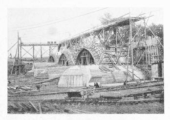
Abb. 20. Rüstungen für die Gewölbe-Betonierung der rechtsufrigen Vorlandöffnungen, südl. Hälfte (25. IX. 12).
