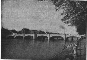
Millere Cheinhrücke in Basel, 200 m lang n. 18 m breit (Verkleidung sämtlicher Flächen in Gotthardgranit).
