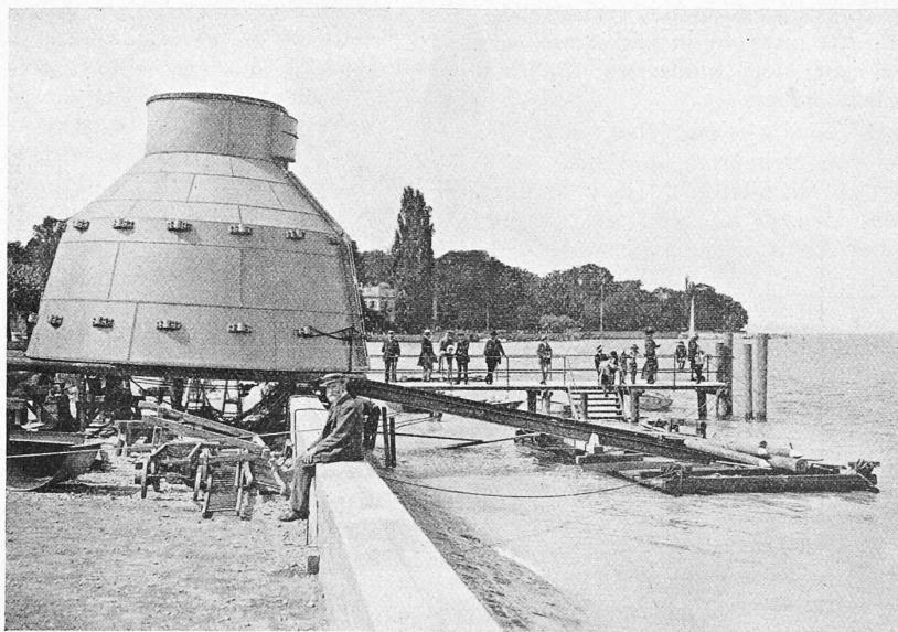
Abb. 2. Stapellauf des Caisson zur Hilfspumpstation der Genfer Seewasserleitung.
