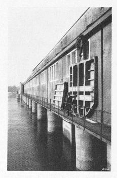
Abb. 14. Bewegliche Schützentafeln zum Abschluss der Ablaufkammern.
