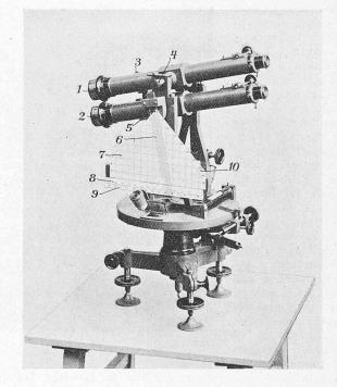
Abb. 1. Fernrohr-Distanzmesser Patent J. Zwicky.
