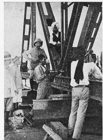
Abb. 5. Pneumatische Nietung.
