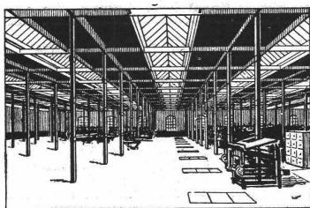
1. Empfohlen als rationelles System für Spinnereien, Webereien, Färbereien, Bleichereien, Maschinenfabriken, Montierungs- hallen, Werkstätten, Elektrische Zentralen, Gießereien, Güterhallen. Mehr als dreissigjährige Erfahrungen im Bau industrieller Anlagen. Ueber 400 000 m<sup>2</sup> ausgeführt.
