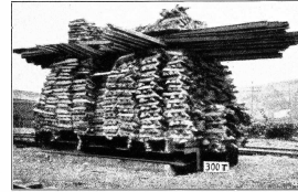
Probebelastung auf 5 Pfählen mit 300 t Fig. 4
