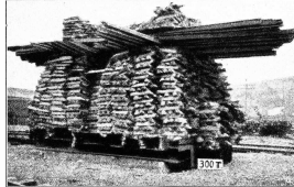
Probebelastung auf 5 Pfählen mit 300 t Fig. 4
