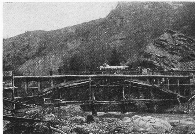
Abb. 10. Belastungsprobe der Glennerbrücke.
