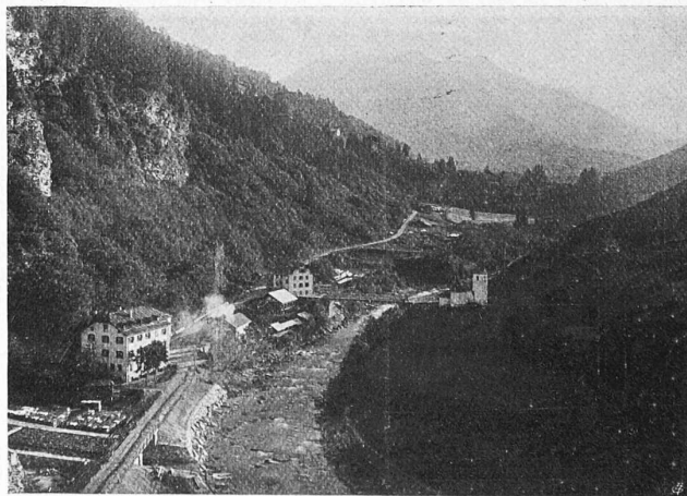
Abb. 9. Ende der neuen Strasse beim Bad Peiden.
