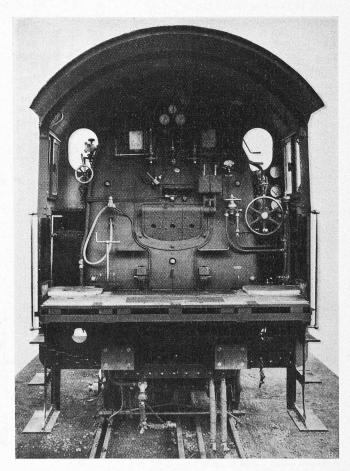
Abb. 16. Anordnnng der Armaturen im Führerstand. — 1:35.
