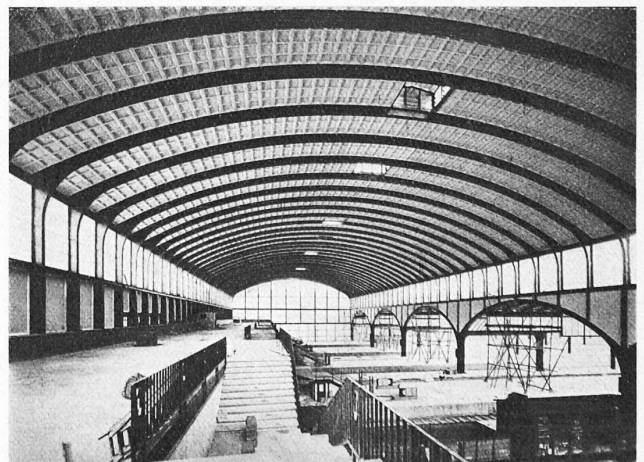
Abb. 30. Querbahnsteighalle im Hauptbahnhof Darmstadt mit Remyschen Bimszement-Kassettenplatten gedeckt. Spannweite der Halle 34,0 m, Binderabstand 2,6 m.
