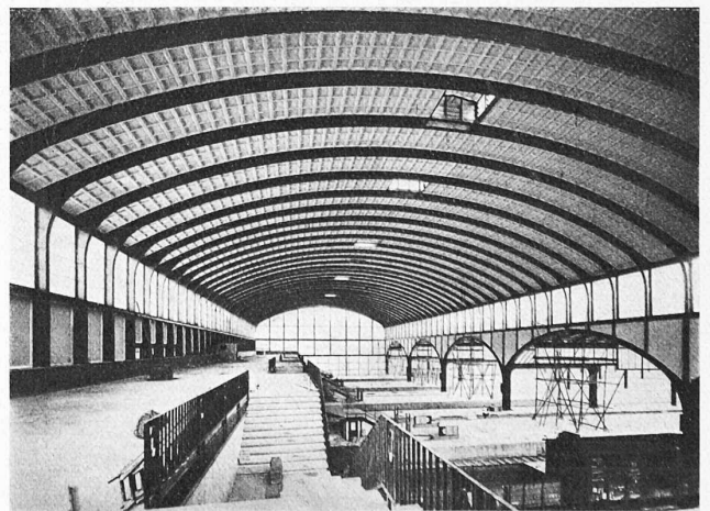
Abb. 30. Querbahnsteigehalle im Hauptbahnhof Darmstadt mit Remyschen Bimszement-Kassettenplatten gedeckt. Spannweite der Halle 34,0 m , Binderabstand 2,6 m .
