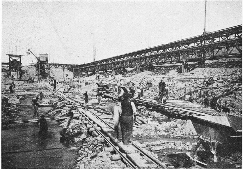
Abb. 80. Blick stromaufwärts in die Turbinenhaus-Baugrube (20 V. 1910).
