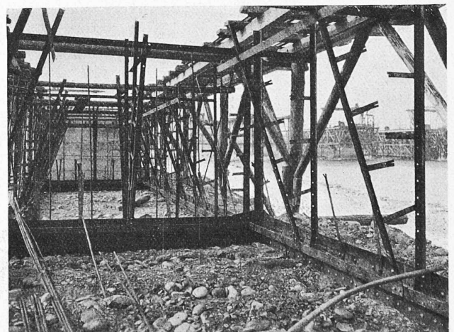
Abb. 76. Montage der Betoncaisson-Armierung (Januar 1909).
