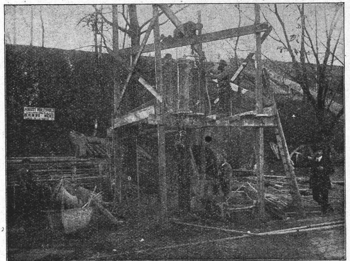
Selbsttätiges Hochsteigen des Bohrrohres aus der Erde unter der Wirkung der aufgelassenen Preßluft bei gleichzeitiger Komprimierung des Pfahlbetons und der benachbarten Erdschichten.
