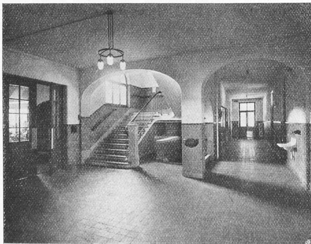
Abb. 13. Halle im Erdgeschoss des Hauptgebäudes.
