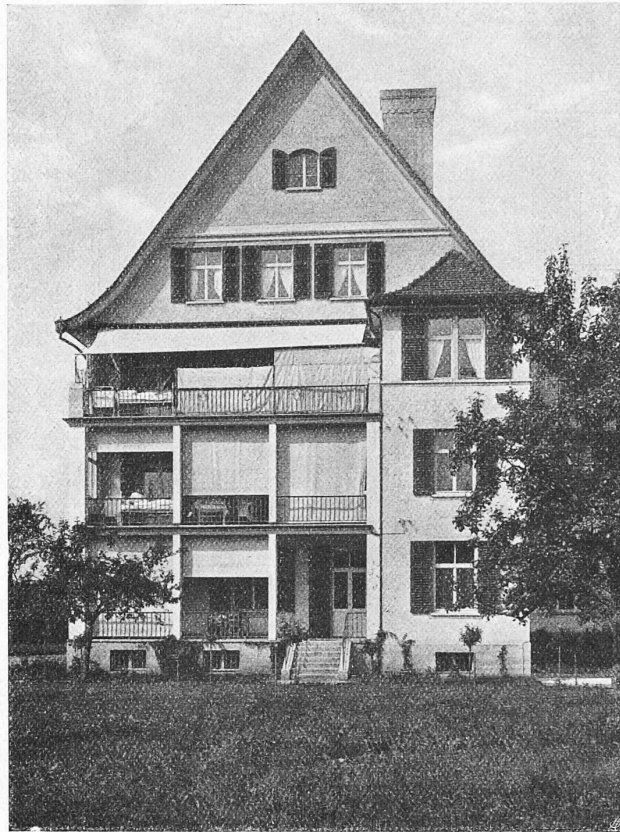
Abb. 12. Südost-Giebelfront des Hauptgebäudes.
