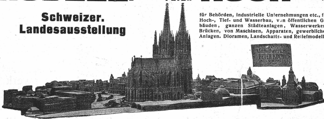
Modell der Umgebung des Cöln-Domes mit auswechselbaren Gebäudegruppen im Masstab 1:100. Turmhöhe 1,70 m, Modellgrösse 30 qm.
