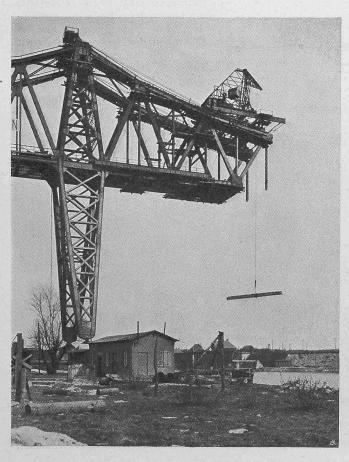
Abb. 17. Freivorbau der Kanalbrücke bei Rendsburg.
