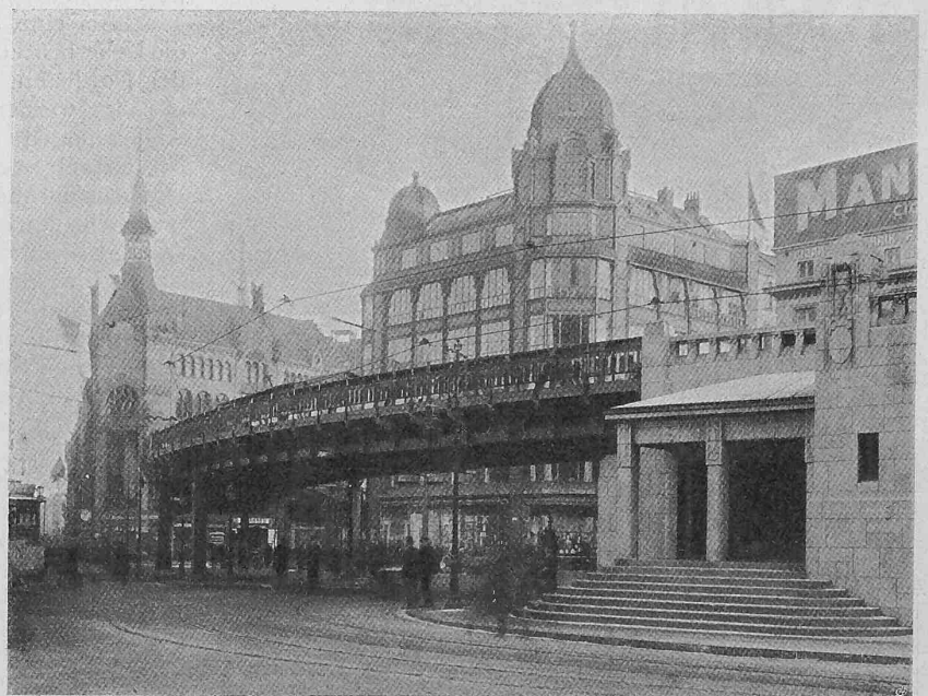
Abb. 22. Gekrümmter Viadukt der Hamburger Hochbahn am Rödingsmarkt.
