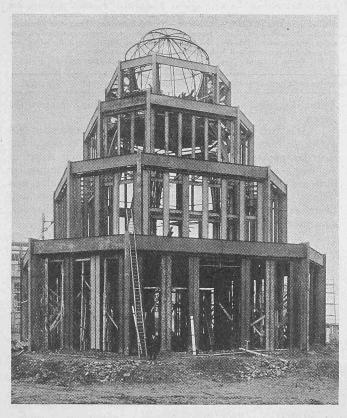
Abb. 2. Das Monument des Eisens im Rohbau.
