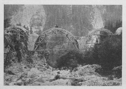
Abb. 8. Lehrgerüst des Calfreiser-Viadukts, Betonquader-Herstellung.
