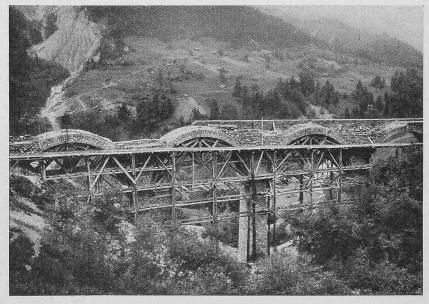
Abb 13. Lochbächli-Viadukt mit Dienststeg (6 VII. 1913).
