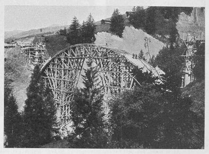
Abb. 17, Fertiges Lehrgerüst zum Gründjetobel-Viadukt (31. VIII. 13).
