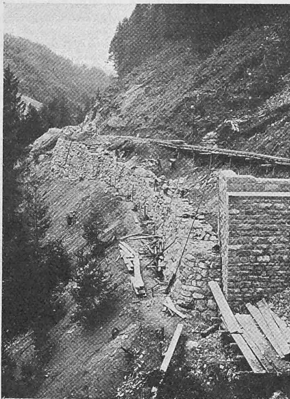
Abb. 5. Stützmauer Km. 3 831 / 915 (30. VI. 13).
