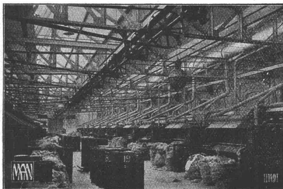
Absaugungs-Anlage für Karderie. S. A. Linière La Lièvre, Gent (Belgien)
