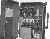
Freileitungs-Schalter Schaltkasten Type K.
