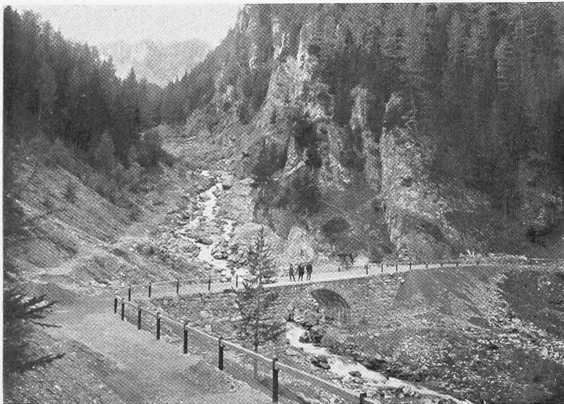
Abb. 13. Brücke im Val Sampuoir (Km. 13,4).
