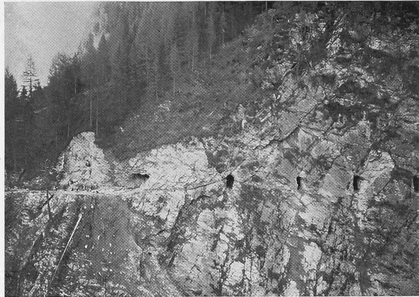
Abb. 12. Fernertobel-Tunnel mit Fenstern, 238 m lang.
