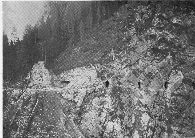
Abb. 12. Fernertobel-Tunnel mit Fenstern, 238 m lang.
