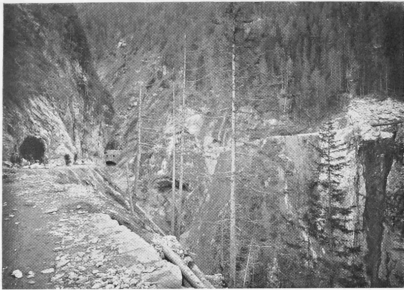
Abb. 11. Tunnel und Galerie im Fernertobel (Km. 8,9 bis 9,4).
