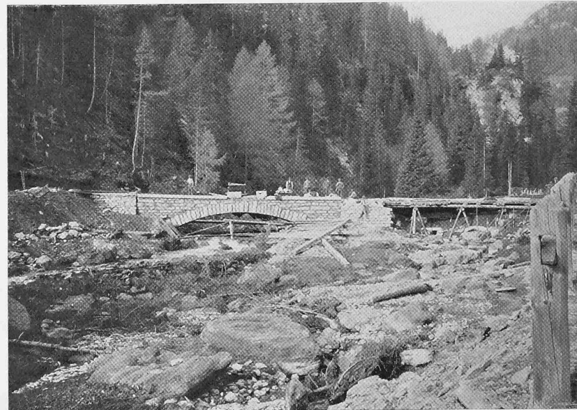
Abb. 14. Schergenbachbrücke bei Km. 14,7.
