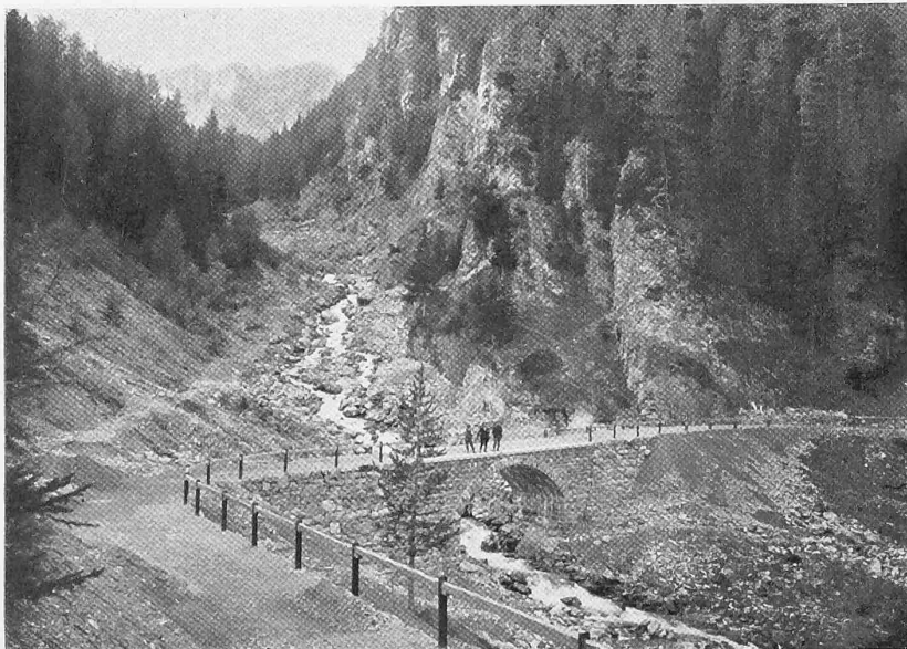
Abb. 13. Brücke im Val Sampuoir (Km. 13,4).
