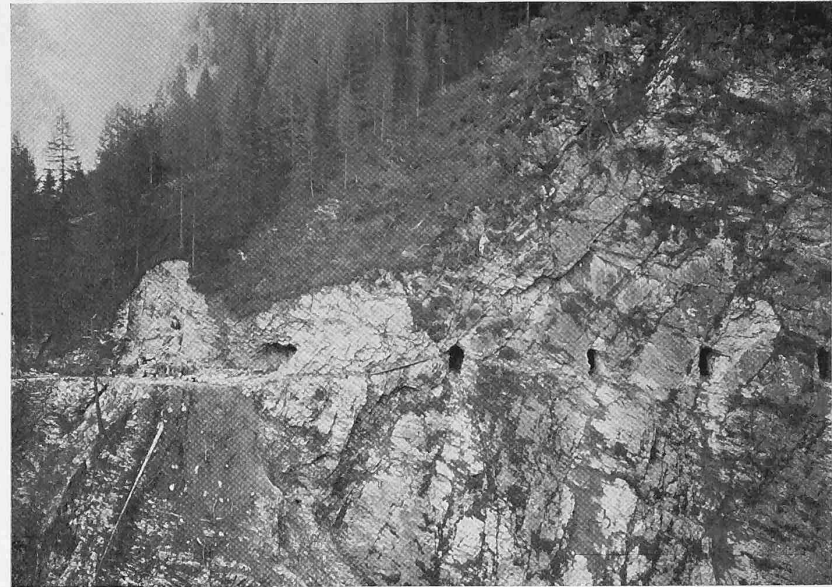
Abb. 12. Fernertobel-Tunnel mit Fenstern, 238 m lang.
