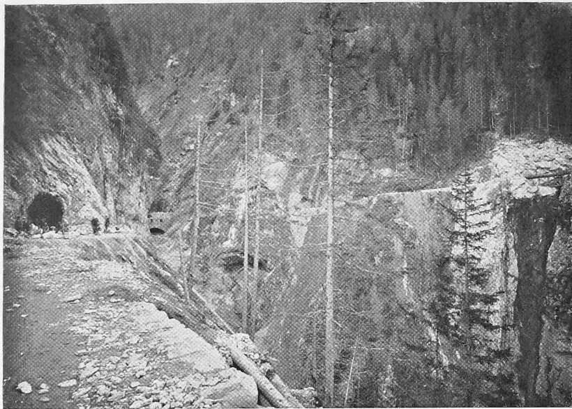
Abb. 11. Tunnel und Galerie im Fernertobel (Km. 8,9 bis 9,4).
