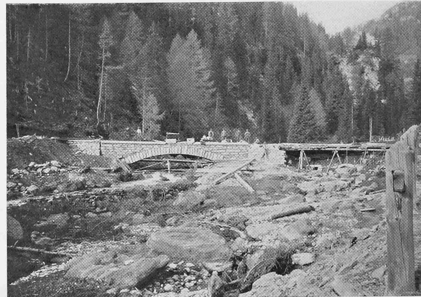
Abb. 14. Schergenbachbrücke bei Km. 14,7.
