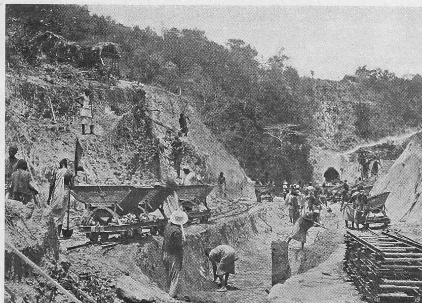
Abb. 13. Förderung mittels Kippwagen im Einschnitt bei Km. 21.
