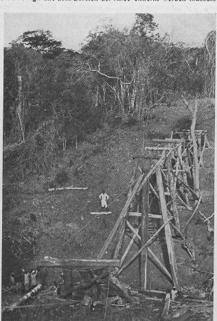
Abb. 11. Dienstbrückenbau zur Umfahrung einer Baustelle bei Km. 24.
