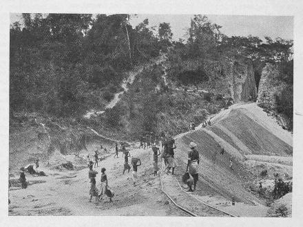
Abb. 12. Dammschüttung mittels Weidenkörben aus Seitenentnahme.
