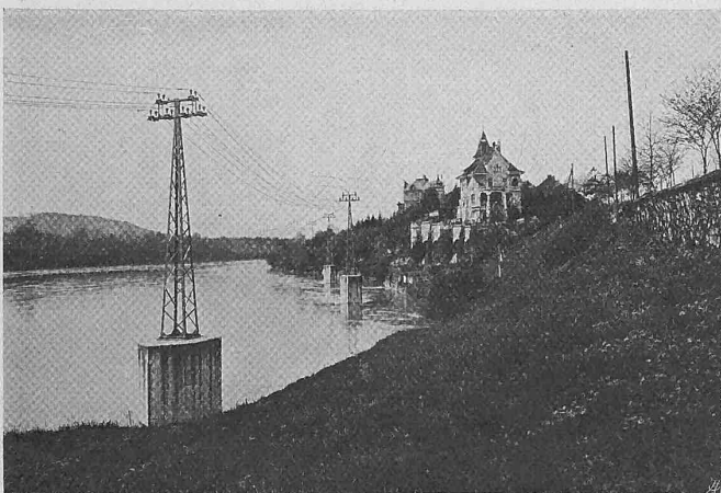
Abb. 71. 25 000 Volt-Leitung Rheinfelden-Wyhlen; Masten im Rhein unterhalb Badisch-Rheinfelden.
