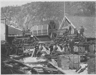
Abb. 35. Rotor zwischen Schmalspur-Spezial-Rollschemeln.
