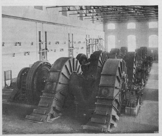
Abb. 31. Maschinensaal der Hauptzentrale Vigeland; an der Wand die Sammelschienen.
