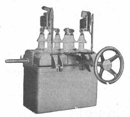
Oelschalfer mit direkter Maximalauslösung
