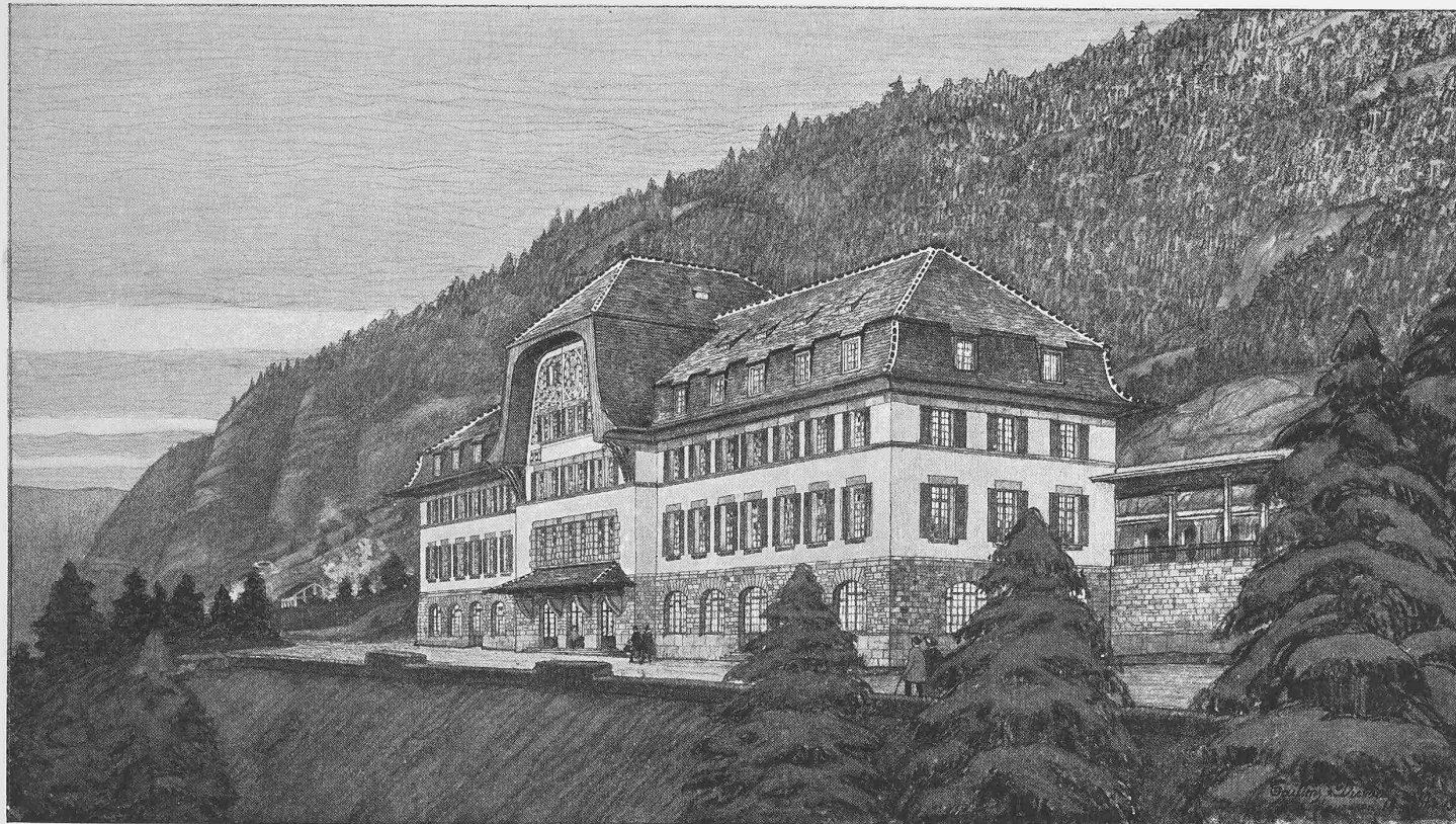
AUFNAHMEGEBÄUDE IM NEUEN BAHNHOF VALLORBE DER SCHWEIZERISCHEN BUNDESBAHNEN
