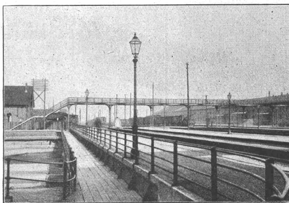
Passerelle Hauptbahnhof Zürich. Eisengewicht 28 Tonnen.
