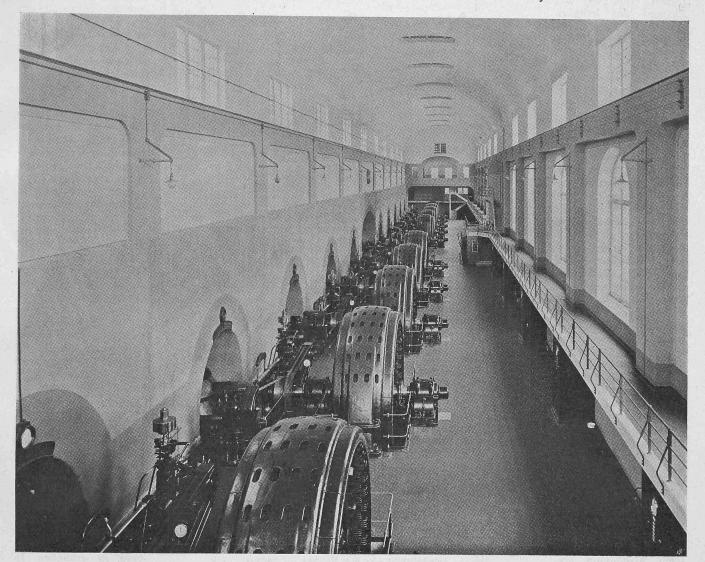
Abb. 24. Maschinensaal des Wasserkraftwerks Wyhlen mit den zehn A.E.G.-Generatoren zu je 2600 KVA.
