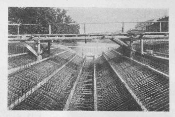
Abb. 14. Armierung über einem Pfeiler (26. VII. 1912).
