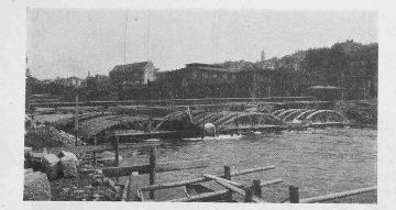
Abb. 13. Fertig aufgestellte Lehrbogen (25. VI. 1912).
