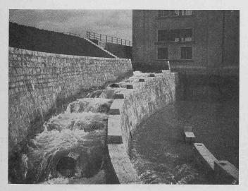
Abb. 11. Kanalfischtreppe des Wasserkraftwerks Wyhlen.
