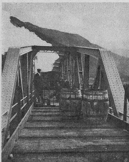
Abb. 5. Blick talaufwärts in die untere Einfahrt der Innbrücke bei Zernez.
