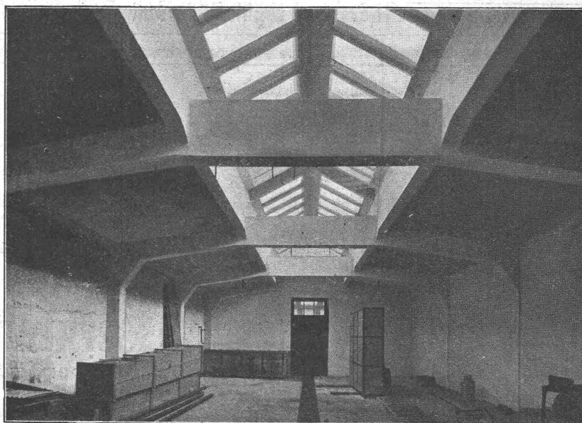
Färberei - Neubau in Eisenbeton.
