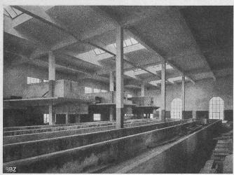
Abb. 10. Aufbereitung, Separatoren und Sandfänge.
