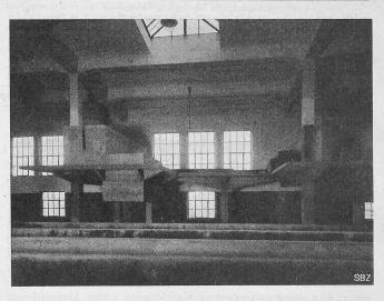
Abb. 9. Aufbereitung, Separatoren und Sandfänge.
