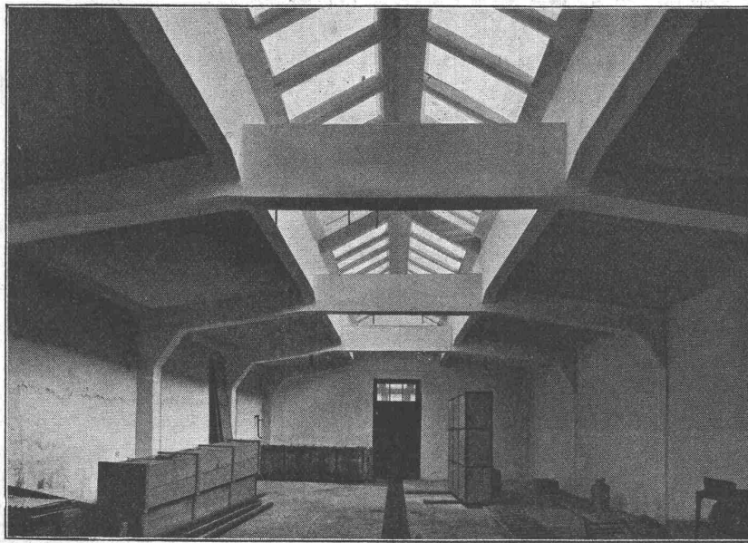
Färberei-Neubau in Eisenbeton.
