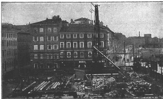
Fundierung des Grand Hôtel Excelsior, Triest mittels Eisenbetonpfählen, System Züblin. Bild: Bauplatz.
