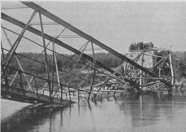
Abb. 3. Ansicht vom linken Ufer, Oberwasserseite.
