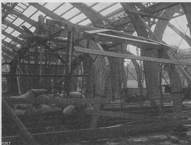
Abb. 14. Vorn links Binder I, hinten rechts Binder II.
