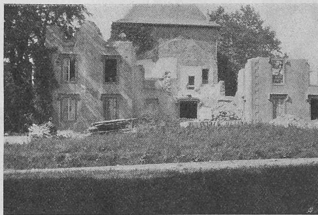
Abb. 4. Abbruch des alten Anbaues, von Süden gesehen.
