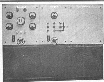
Schalttafel mit eingebauten von vorne regulierbaren Oelschaltern.
