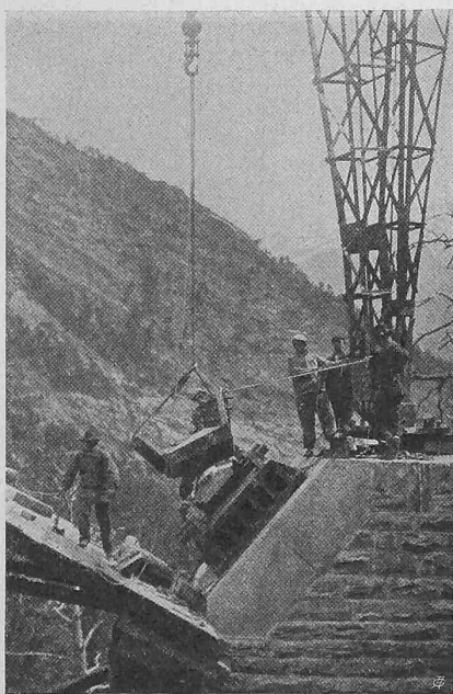
Abb. 18. Versetzen eines Auflagers am Widerlager rechts (18. V. 12).
