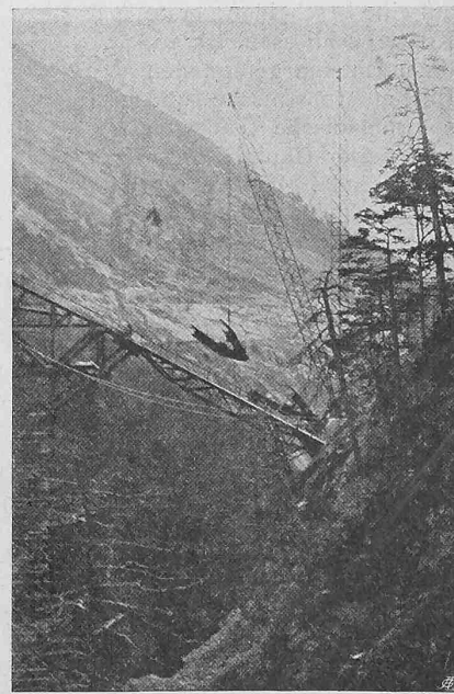
Abb. 19. Versetzen eines Bogenbein-Endgliedes am Auflager rechts (20. V. 12).
