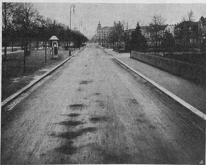
Abb. 1. Beschädigte Strassendecke aus Grauwackenschotter.
