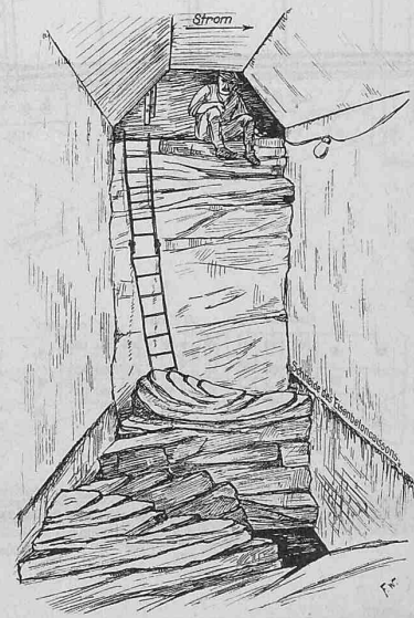
Abb. 26. Arbeitskammer im vertieften Caisson 5 b; Blick gegen Pfeiler IV.
